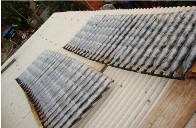
A figura abaixo indica a forma de instalação: caixa d'água/reservatório; reservatório/coletores; coletores/reservatórios; reservatório/chuveiro(residência).
