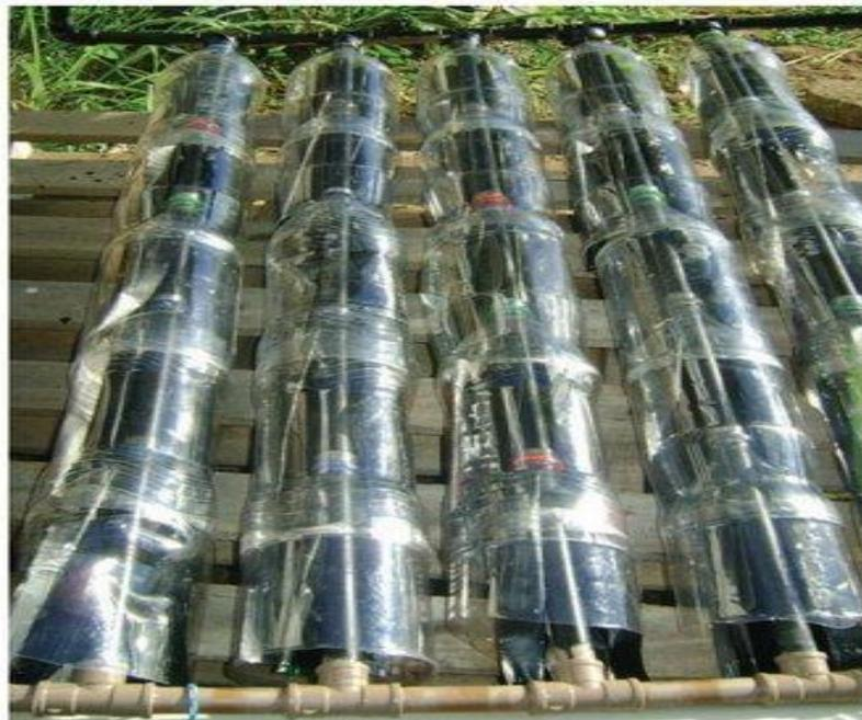
Instalar os coletores com uma inclinação de, no mínimo 5 cm por coletor. Isso é importante para evitar que se acumulem bolhas de ar dentro do sistema. Dessa maneira as bolhas tendem a subir pelo sistema até o reservatório. Importantíssimo: Bolhas de ar presas no circuito podem comprometer totalmente o funcionamento do sistema.
