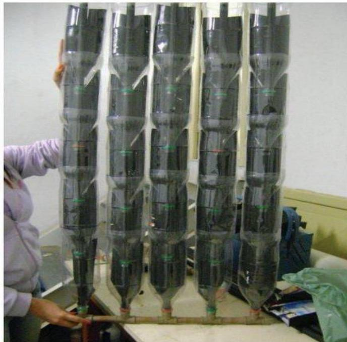
Nos módulos deve-se utilizar uma fita de auto fusão para fixar os tubos de 1m com os barramentos inferior e superior. Um pedaço da fita deve ser esticado e envolvido na conexão T do barramento superior em contato com a garrafa PET, como na figura abaixo:
